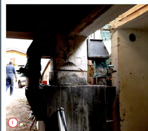
STRUTTURA ISOLATA_PIANO DI SCORRIMENTO
