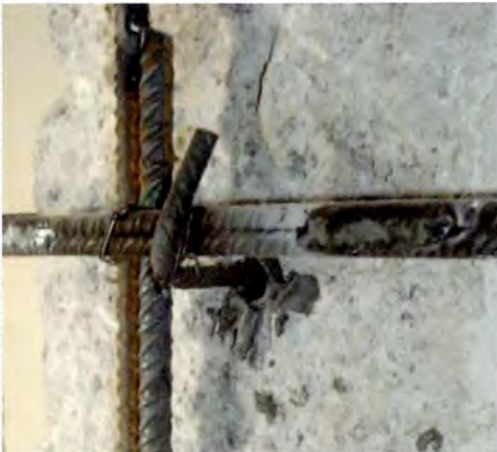
Perno inserito tramite fissaggio chimico
