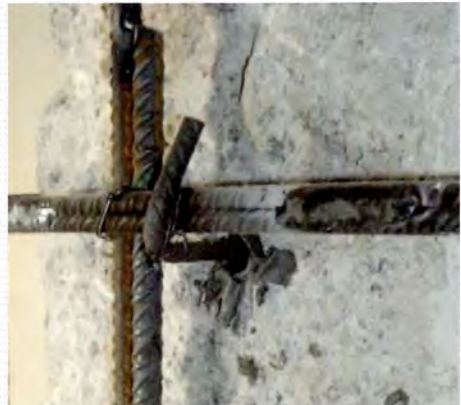
Perno inserito tramite fissaggio chimico
