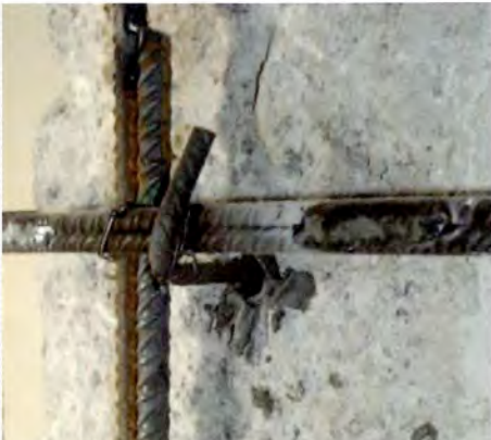
Perno inserito tramite fissaggio chimico
